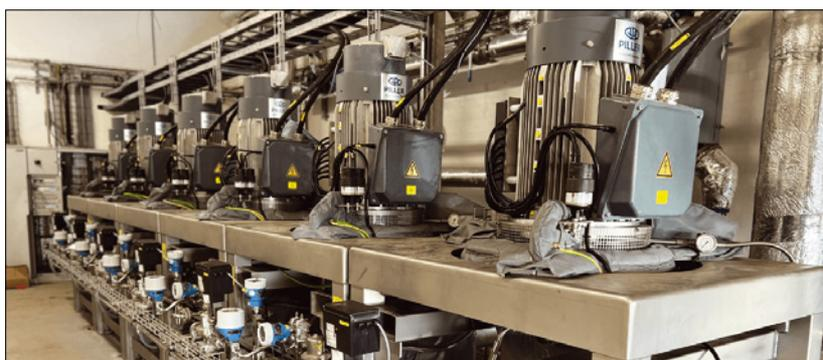
Figura 4 - Vista de un Tren Mecánico de Recompresión de Vapor
