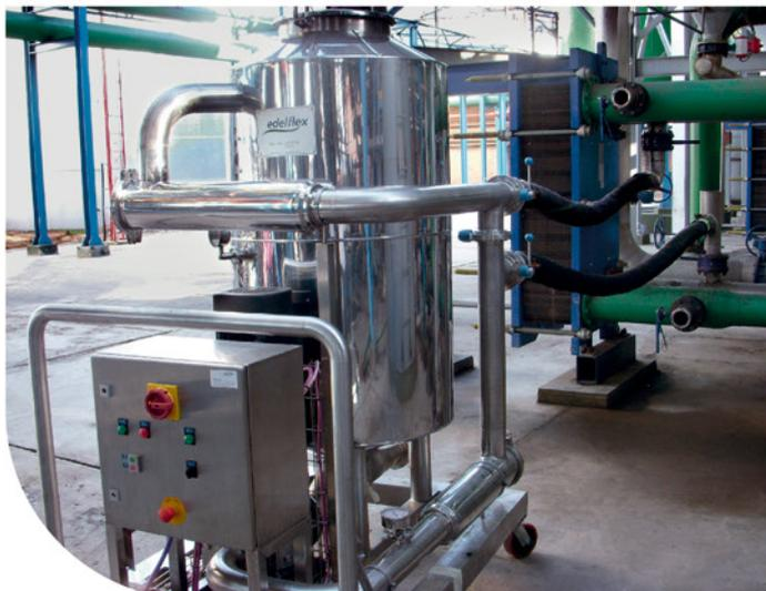
Para prevenir una pérdida de eficiencia del equipo debido al ensuciamiento de las placas, se recomienda realizar un proceso de limpieza CIP. **La limpieza CIP (Cleaning in Place - Limpieza in situ)** consiste en un fluido de limpieza que fluye por el intercambiador sin necesidad de desarmar el equipo. Los restos de suciedad son quitados por el poder disolvente del fluido de limpieza y por el efecto mecánico del flujo turbulento. Para lograr esto se pueden utilizar dos tipos de equipos:
